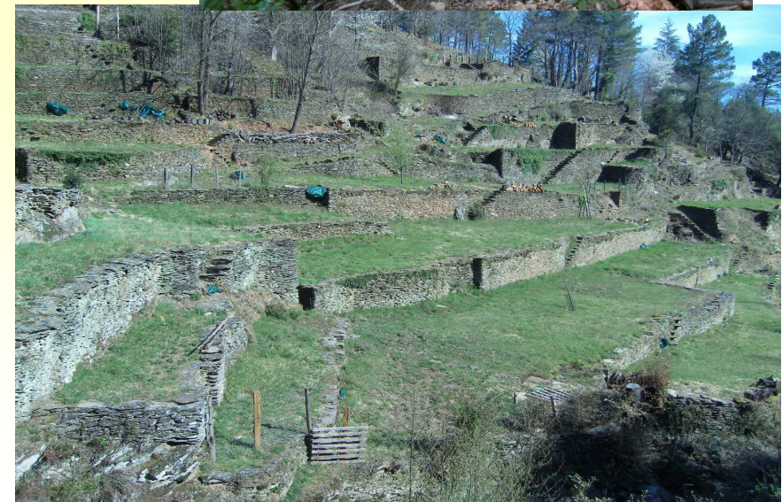
Galeizon : restauration bancels (photos DMD)
